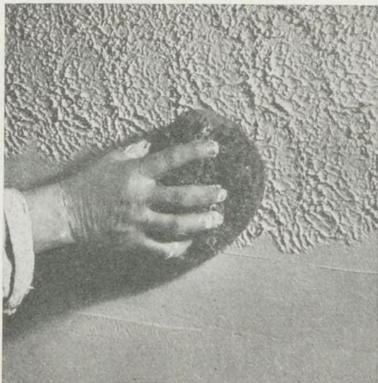
Fig. 1. Kalkstensimitation, første Stadium. Calsorelief-Massen duppes med en Svamp.
