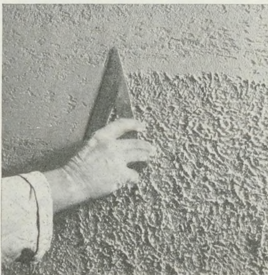
Fig. 2. Kalkstensimitation, andet Stadium. Den duppede Overflade glattes til en vis Dybde med en Tegnerekant.
